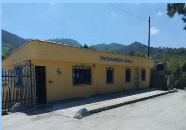
Fotografía 1.7. Entrada a las Oficinas de la Cantera de Orgaleyo
