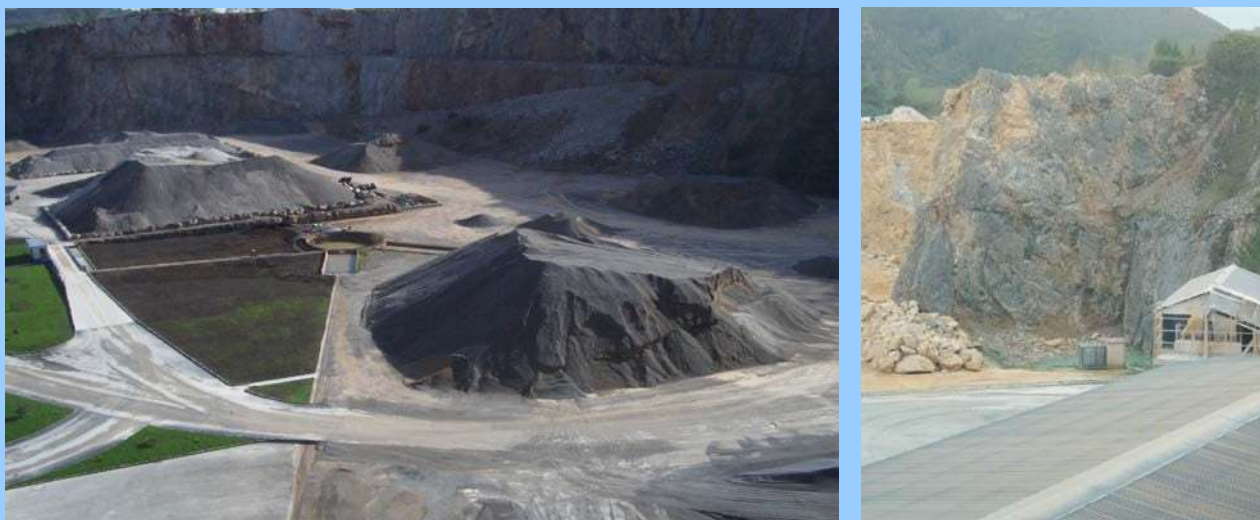
Fotografía 5.1. Balsas de Decantación para Reutilización de Aguas.
