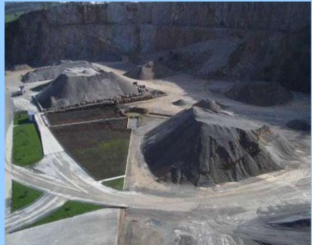
Fotografía 4.2. Balsa General de Recogida de Aguas Cantera de Brañes
