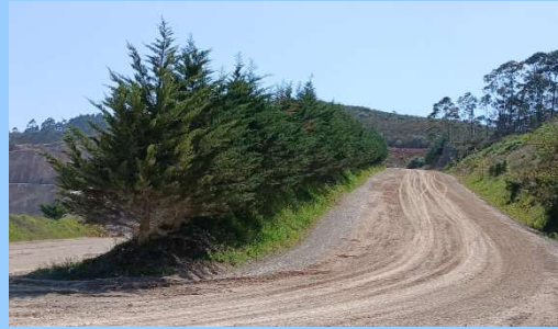
Fotografía 1.3. Plantación para Pantallas Pistas Cantera ya Consolidada, Brañes
