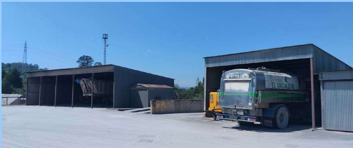
Fotografía 5.4. Naves Para Guardar Toda la Maquinaria
